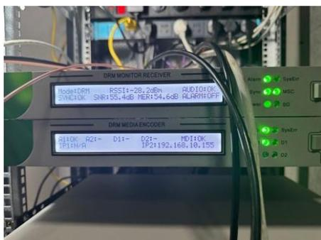
中波发射机改造，载波功率 600kW，DRM 输出功率 350kW，ACPR>40dB，MER>40dB
