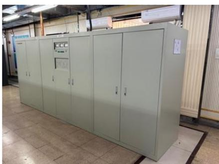
DX 中波发射机改造，载波功率 100kW，DRM 输出功率 40kW，ACPR>40dB，MER>35dB
